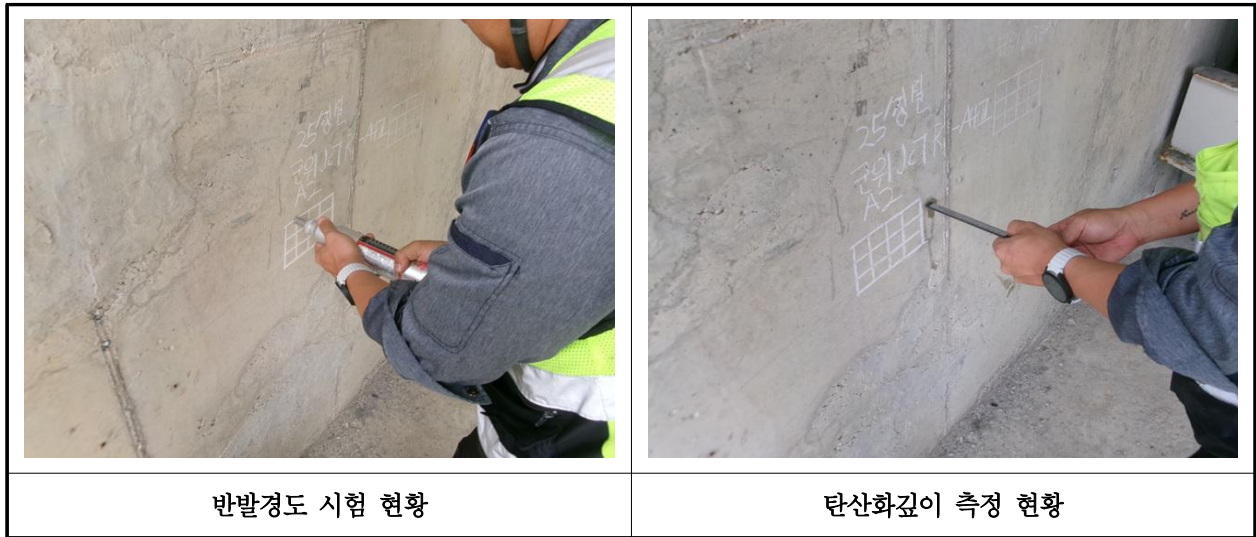
【사진 15.4.1】 콘크리트 내구성조사 현황
