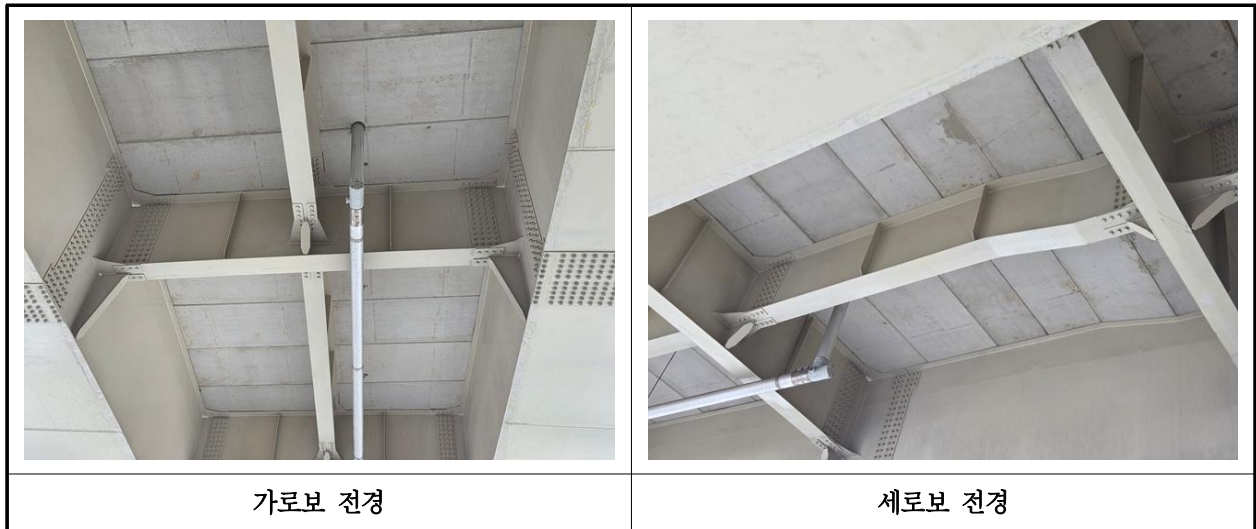
【사진 15.3.6】 가로보 및 세로보 전경
