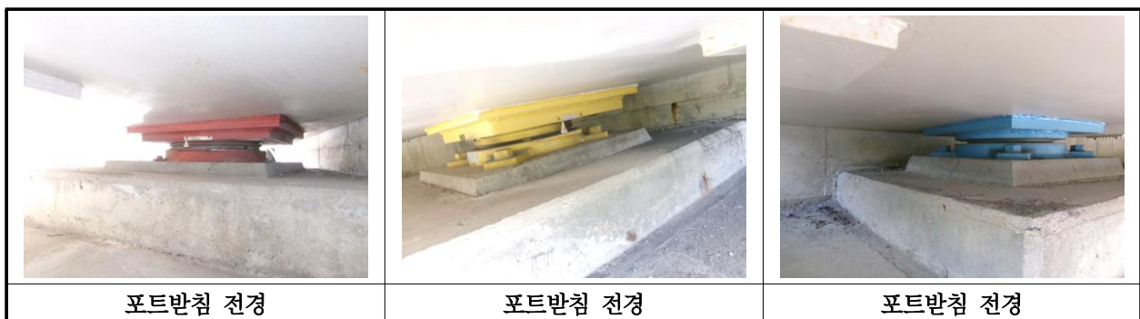
【사진 15.3.11】 교량받침 전경
