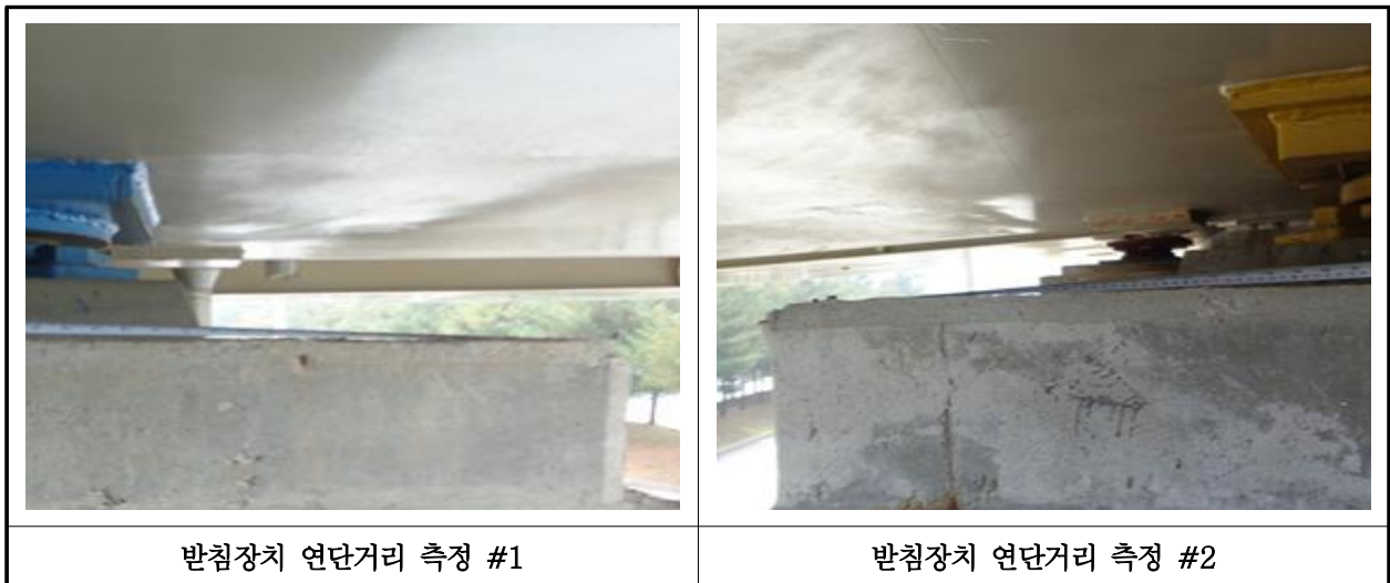
【사진 15.3.13】 교량받침장치 연단거리측정
