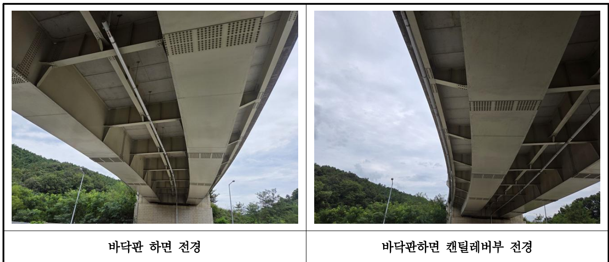
【사진 15.3.2】 바닥판하면 전경
