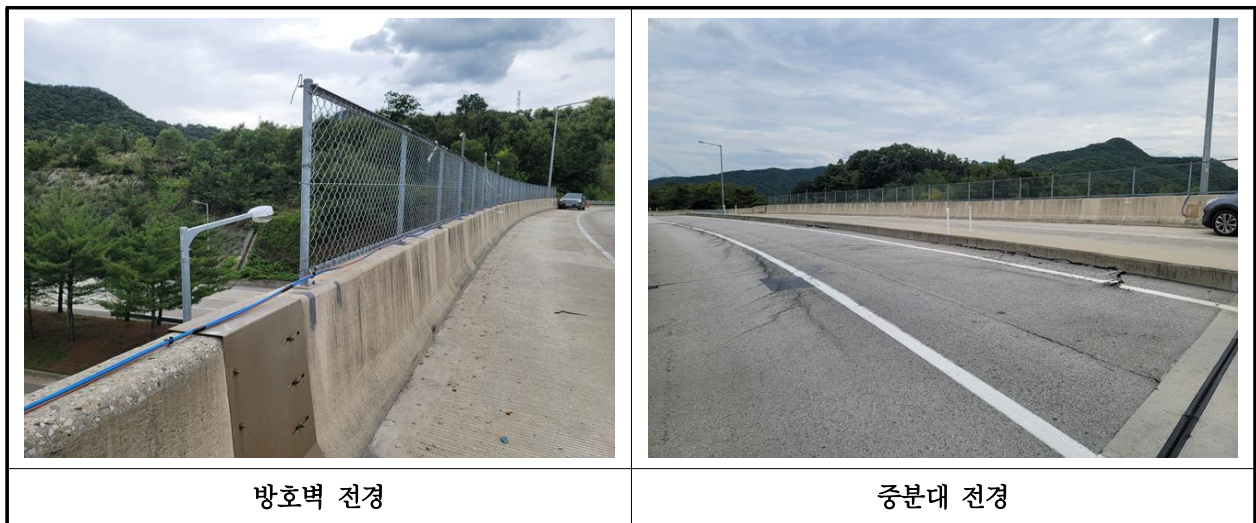
【사진 15.3.22】 방호벽 및 중분대 전경
