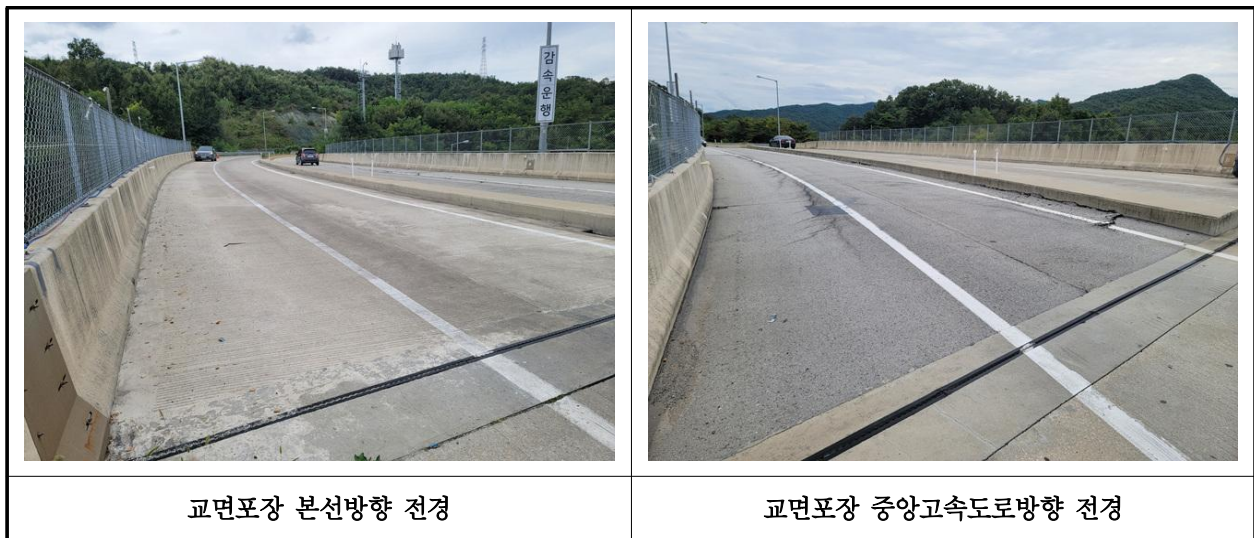
【사진 15.3.18】 교면포장 전경
