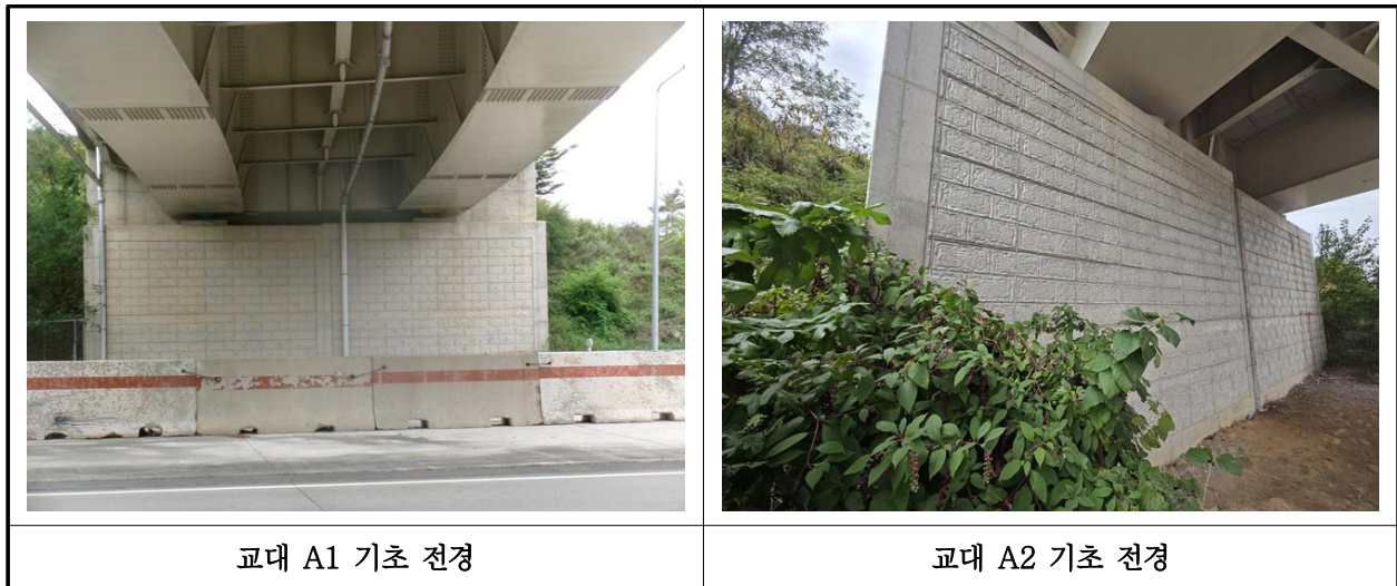
【사진 15.3.10】 기초 전경
