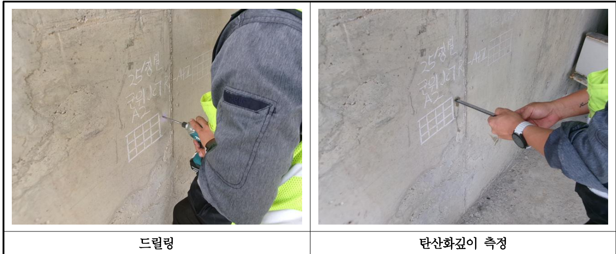
【사진 15.4.3】 탄산화 깊이 측정 현장사진
