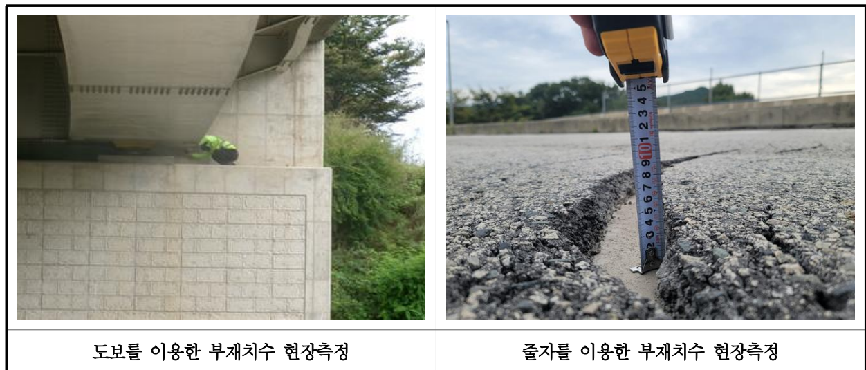
【사진 15.2.1】 부재 현장측정 전경
