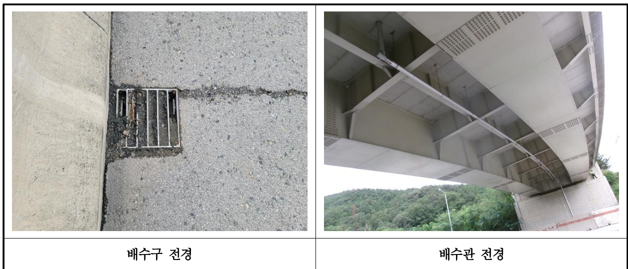
【사진 15.3.20】 배수시설 전경
